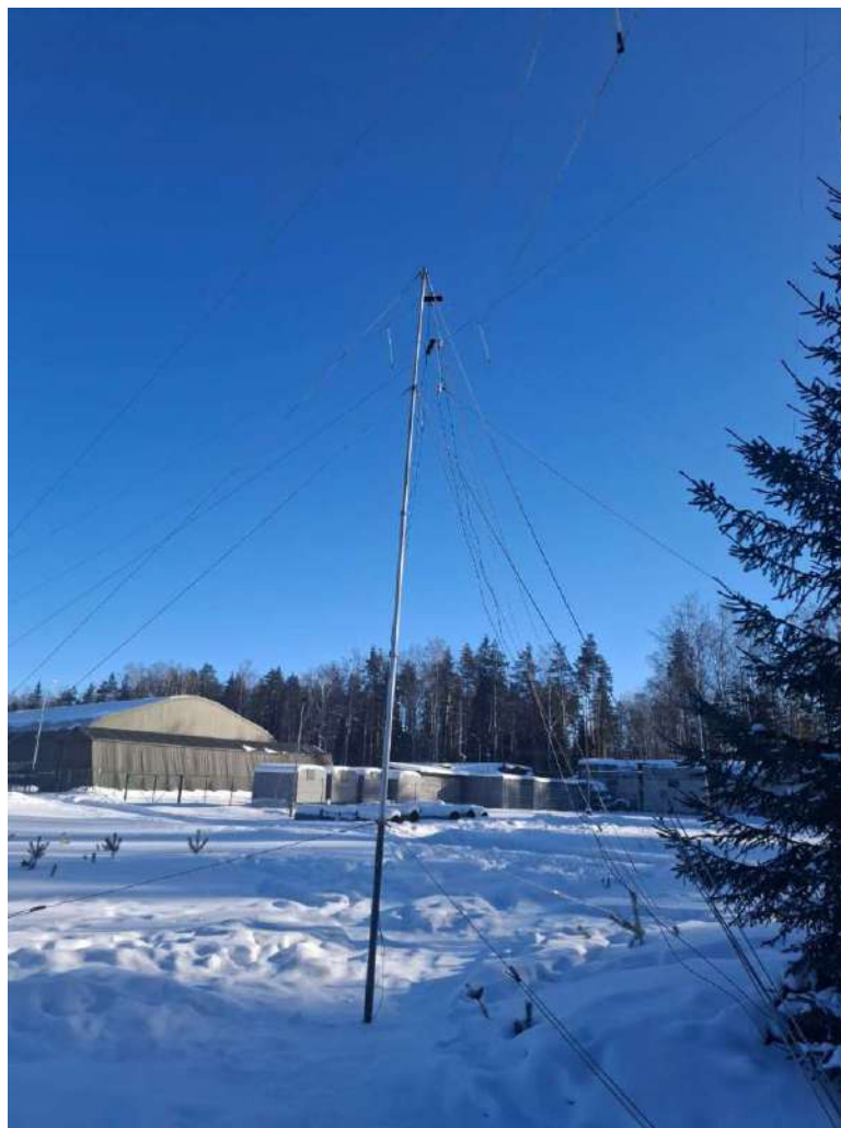
Рисунок 6.34 – Развернутые штатные антенно-фидерные устройства радиостанции «Радиан-КВ»
